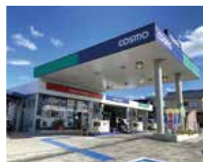
（株）輪島丸善リバーサイドニツ屋 SS（本社事務所併設）
